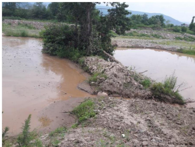
شکل ۴: الف و ب) حوضچه‌های آرامش رسوب در حاشیه معادن شن و ماسه رودخانه شیروود.
