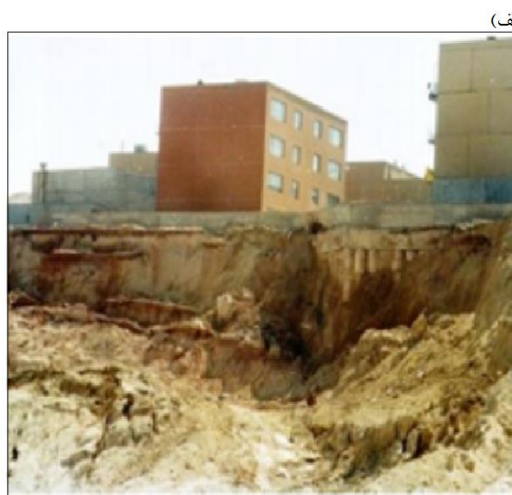
شکل ۴- نمونه‌هایی از مشکلات سازه‌های احداث شده بر روی لایه‌های رسی در شهر تبریز: الف) ناپایداری شیب نگین پارک ولیعصر (Sadrekarimi et al., 2006) ب) انحراف سازه‌ها در اثر نشست، کوی باغمیشه.
