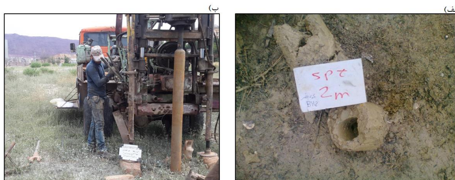
شکل ۶- الف) حفره آزمایش SPT در داخل مغزه رسی (عمق ۲ متری گمانه B 2 ) ب) دستگاه حفاری در محل گمانه B 1
