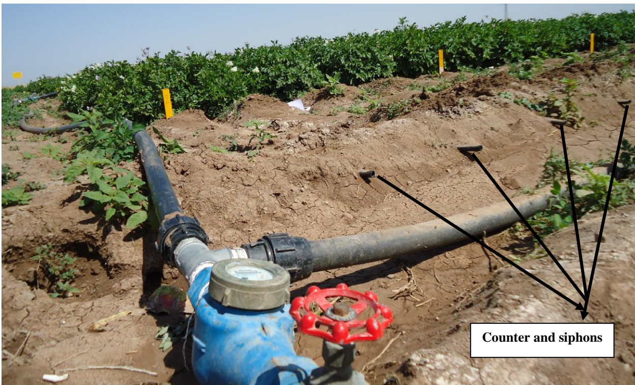
شکل ۱: موقعیت کنتور حجمی و سیفون‌ها در مزرعه Fig. 1: Counter and siphons position in experimental field
