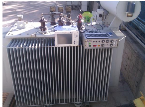
شکل ۱۰: انجام تست عملی بر روی یک ترانسفورماتور توزیع با استفاده از ژنراتور ضربه تک‌پله ولتاژ پایین
