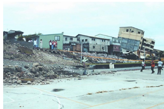
شکل ۱۲. اسکارپ گسلی و پیامد ساخت و ساز در محدوده‌ی اجتناب. اسکارپ گسل معکوس در نتیجه زلزله چی-چی در سال ۱۹۹۹ تایوان که ناحیه گسیختگی گسل در قسمت میانی تا قسمت پایین اسکارپ اتفاق افتاده است. به کج شدن و تخریب ساختمان‌های موجود در بلوک بالادست (فرا دیواره) گسل توجه کنید.
