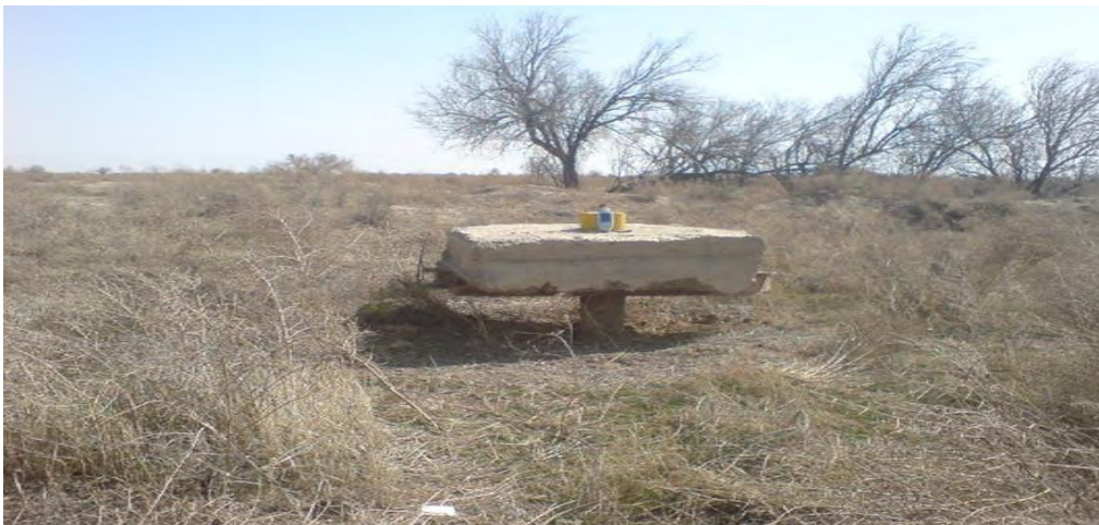
شکل ۴- نشست زمین در ایستگاه نمونه برداری آب زیرزمینی وایقان واقع در دشت شبستر - صوفیان
