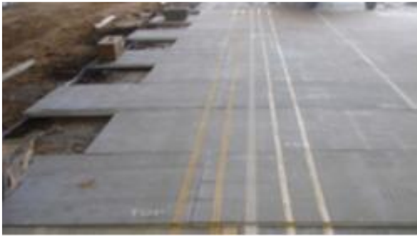
شکل ۱- نمایی از صفحات AM-2 ترمیم‌کننده باند فرودگاه
