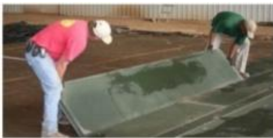
شکل ۱- صفحات آلومینیومی ترمیم کننده باند در حال متصل شدن به هم [۲۲]
