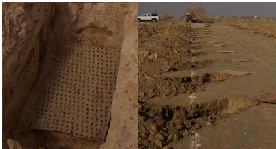
شکل ۲- نحوه کارگذاری صفحه‌های پلانت‌بک در چاله‌های حفرشده
