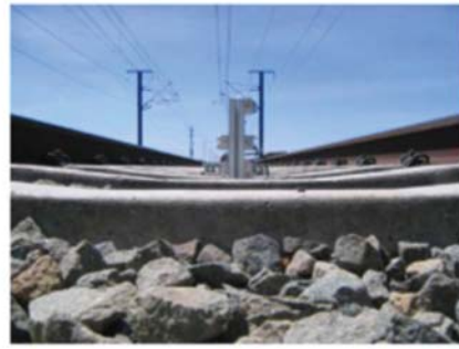
شکل ۳. تنظیم سطح بالاست خط نسبت به تراورس. [۸]
