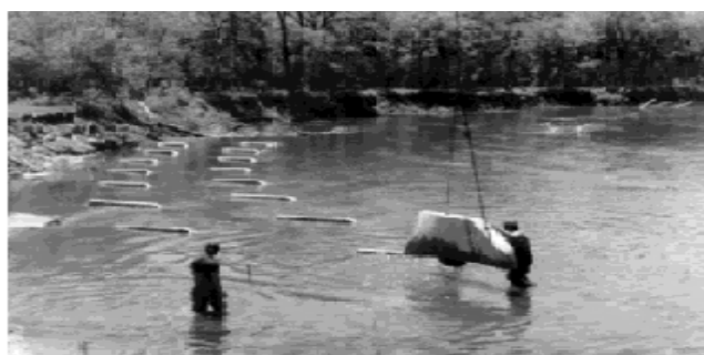
شکل 2- نصب صفحات آیوا بتنی در رودخانه کم‌عمق (بی‌نام 2006).
