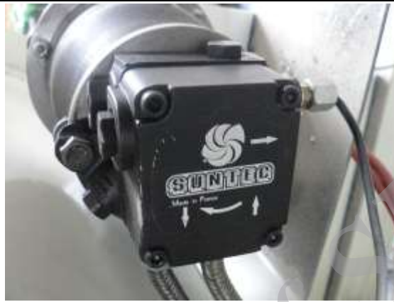
شکل ۴-۴: پمپ سوخت و اتصال آن به موتور پمپ
