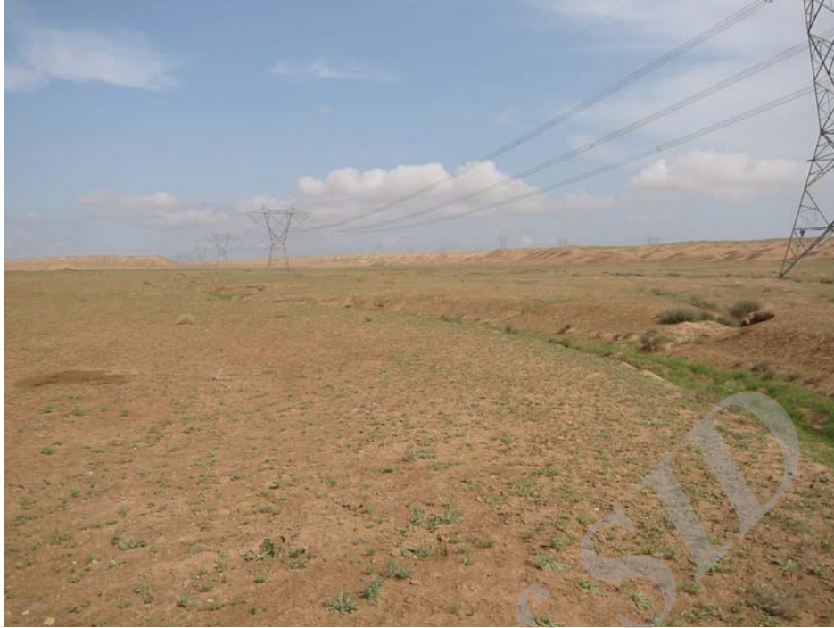
شکل ۵-۳۲- منطقه در مجاورت خطوط برق فشار قوی
