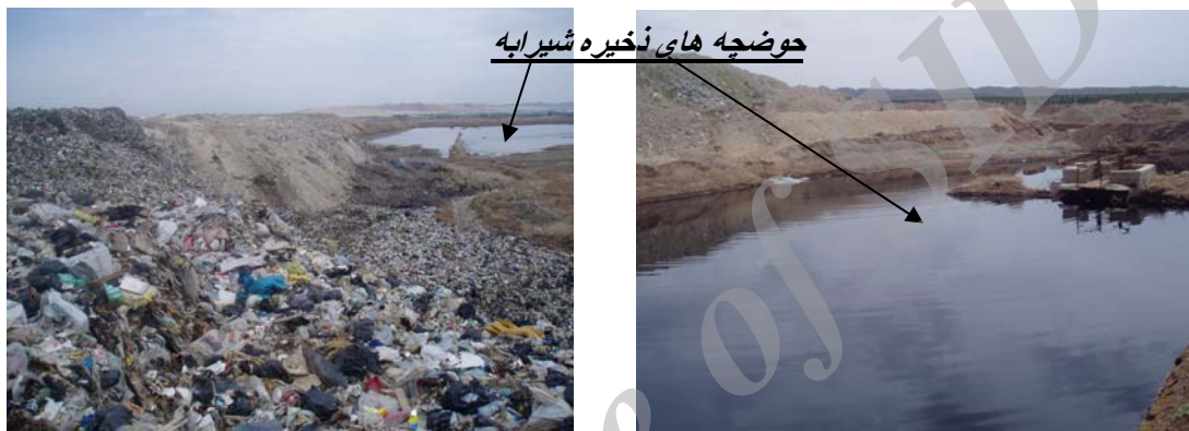
شکل ۲-۴- شمایی از وضع موجود در محل دفن کهریزک
