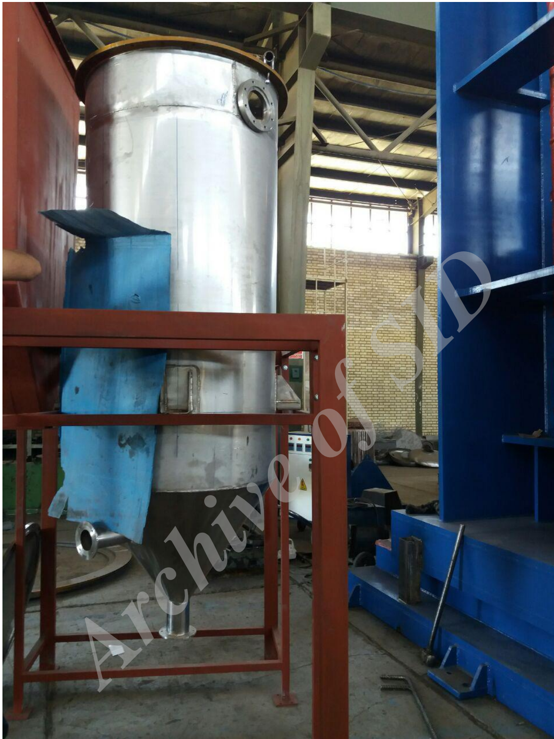
شکل ۱-۱۵- ساخت پلت فرم و نصب مخزن انبساط و فیلتر بر روی آن.
