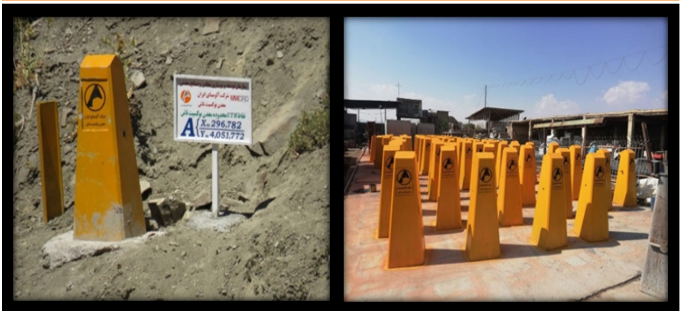
شکل ۶. تصویر شاخص‌های تهیه شده و نمونه‌ای از تابلوی مختصات رئوس و شاخص کار گذشته شده
