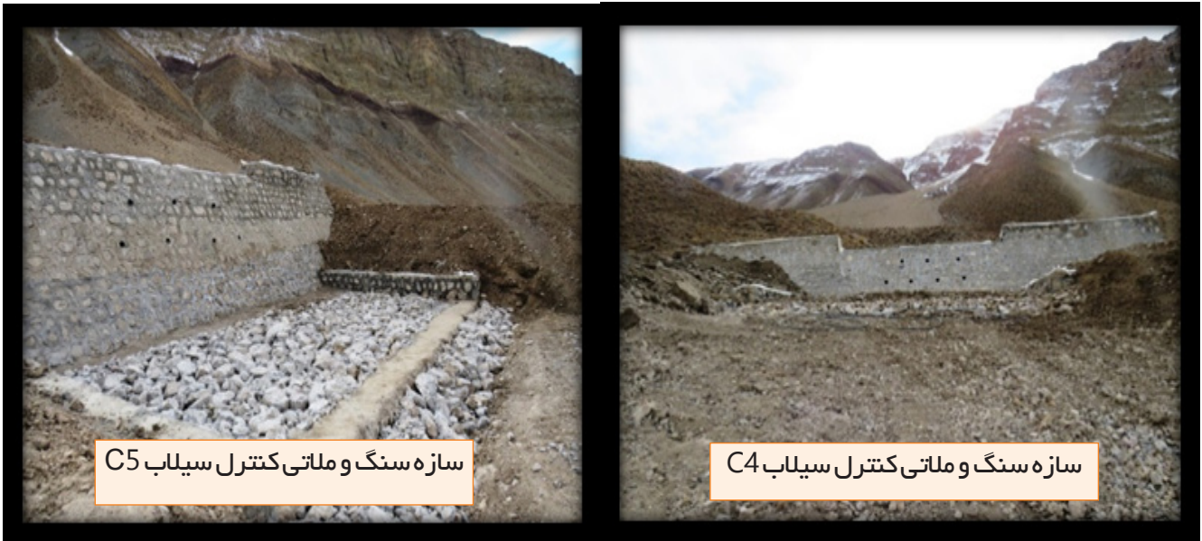
شکل ۱۷. سازه‌های کاهش زیان باری سیلاب احداث شده در معدن بوکسیت تاش
