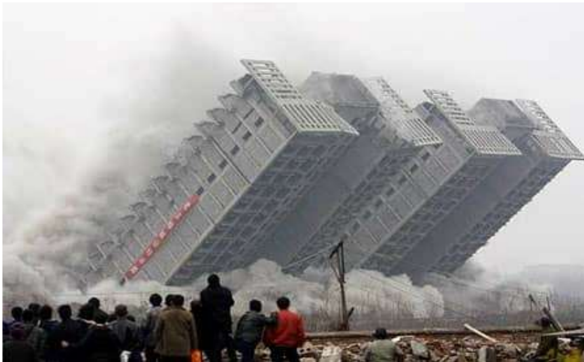
شکل شماره (۳): تخریب به روش انفجار
