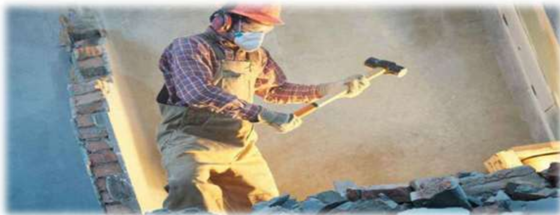
شکل شماره (۲) : تخریب به روش دستی
