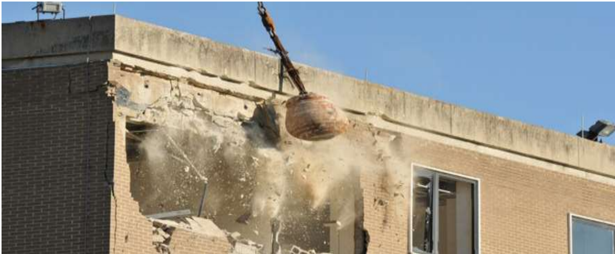
شکل شماره (۵) : تخریب ساختمان به روش گوی تخریب
