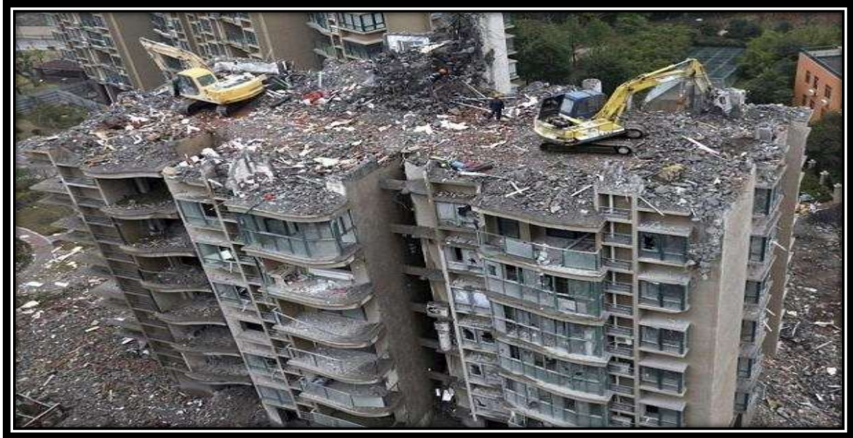
شکل شماره (۴) : تخریب به روش بالا به پایین توسط ماشین آلات
