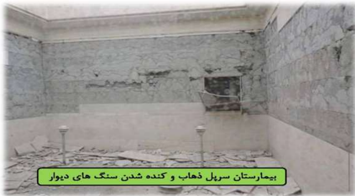
شکل ۲. اتصال نامناسب سنگ ها به دیوار و ریزش آنها
