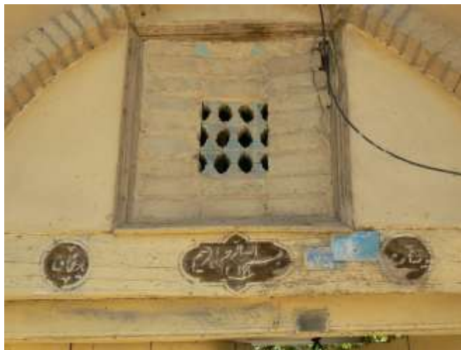
شکل ۴: کلاف چوبی که دور تا دور نورگیر مشبک را در بر گرفته است
