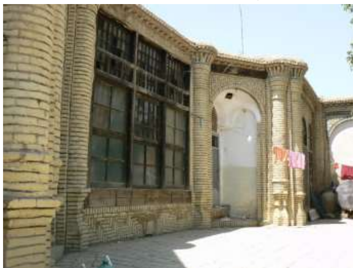
شکل ۵: احاطه کردن پنجره بزرگ به وسیله کلاف‌های افقی چوبی و کلاف قائم آجری
