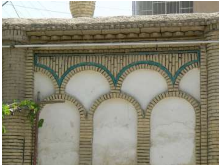
شکل ۱۰: کلاف‌های قائم آجری که به عنوان پشت بند در دیوار محوطه اجرا شده است
