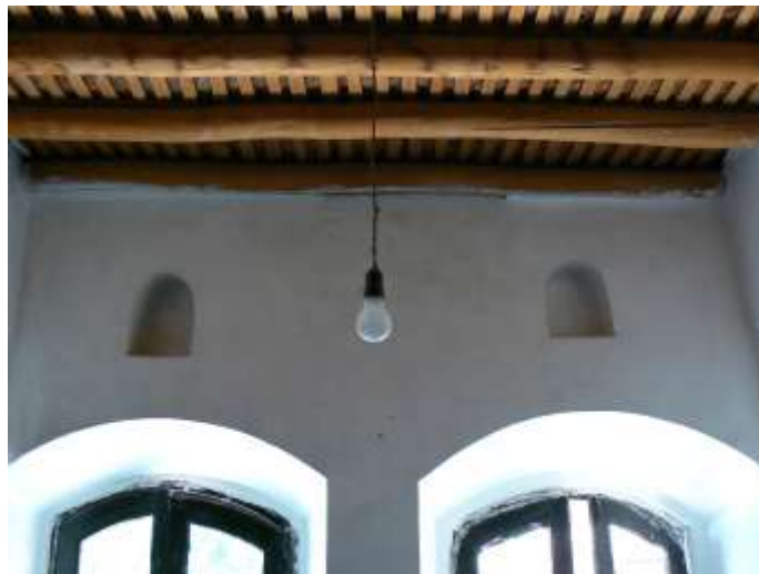
شکل ۱۱: سقف چوبی ساختمان مورد مطالعه
