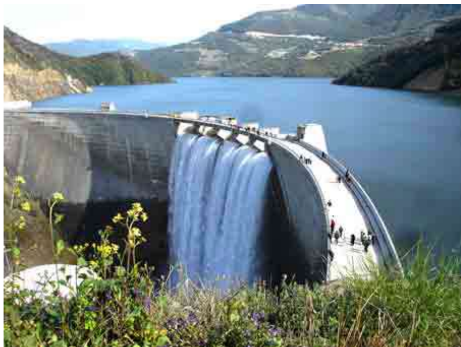
شکل شماره (۲) : نمایی از سد سلیمان تنگه
