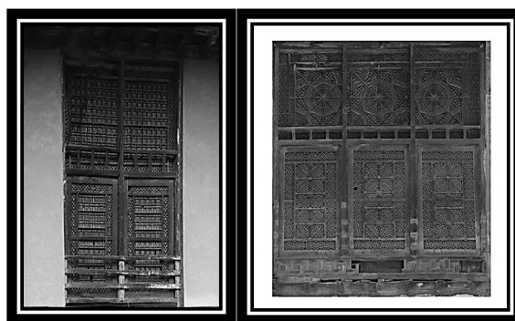
عکس شماره ۶: پنجره نمای شرقی و جنوبی ساختمان منبع ( سلیمانی، ۱۳۹۵: ۱۴)
