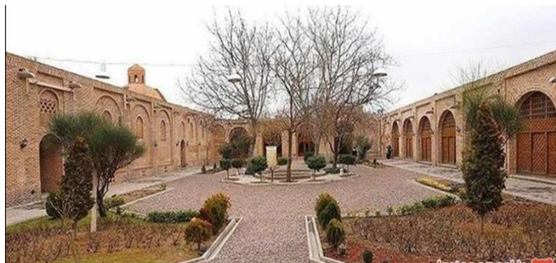
شکل ۳: نمایی از سرای سعدالسلطنه قزوین بعد از بازسازی
