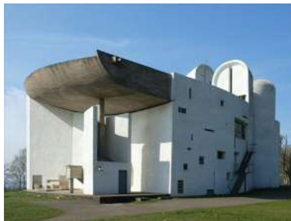
شکل ۶- قرارگیری پنجره ها و نحوه نورگیری از نمای خارج کلیسای نوتردام (disamag.com)
