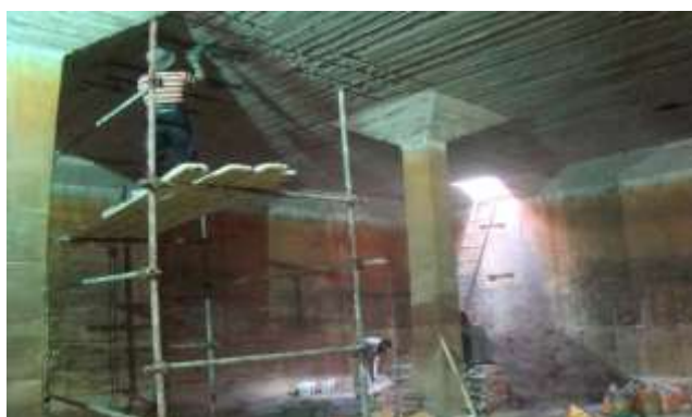
شکل شماره (۱۹) پر نمودن محل های تخریب شده سقف با استفاده از ملات ترمیم کننده در محل میلگرد ها
