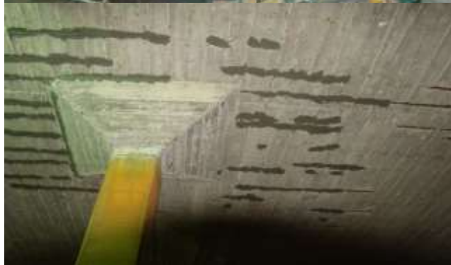
شکل شماره (۲۰) عملیات محلول زنی سقف با استفاده از چسب بتن
