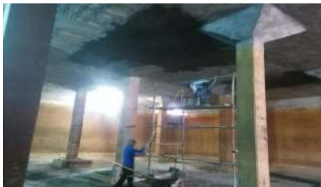
شکل شماره (۲۲) اجرای اندود تگری (لیسه کردن) سطوح سیمان کاری شده
