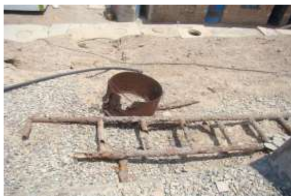
شکل شماره (۱۵) خوردگی پله فولادی مخزن
