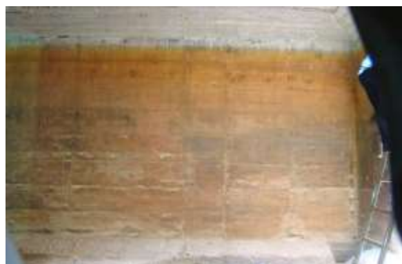
شکل شماره (۶) رسوب گذاری در بدنه
