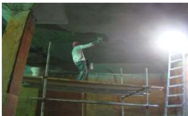
شکل شماره (۲۲) اجرای اندود تگری (لیسه کردن) سطوح سیمان کاری شده
