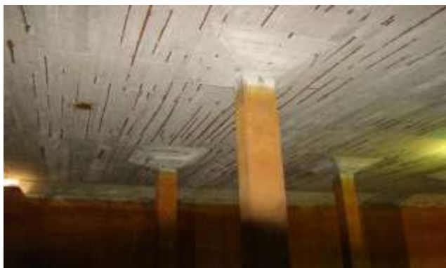
شکل شماره (۱۸) برس زنی و تمیزکاری نقاط آسیب دیده
