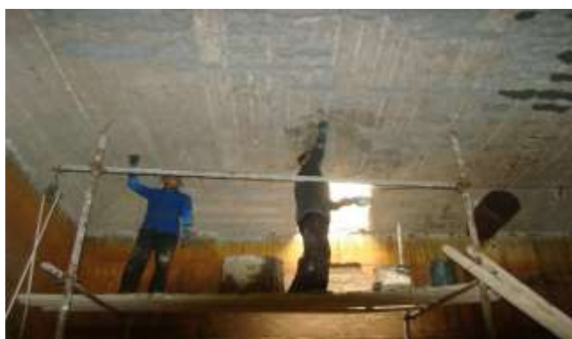
شکل شماره (۲۱) عملیات اندود پاششی سقف طی سه مرحله تا رسیدن به ضخامت حدود ۲ سانتیمتر
