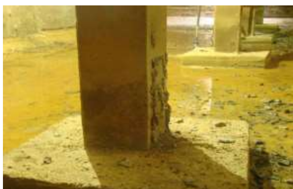
شکل شماره (۵) خوردگی بتن و میلگرد در پای ستونها
