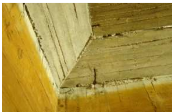
شکل شماره (۴) خوردگی میلگرد در محل ماهیچه زیر سقف
