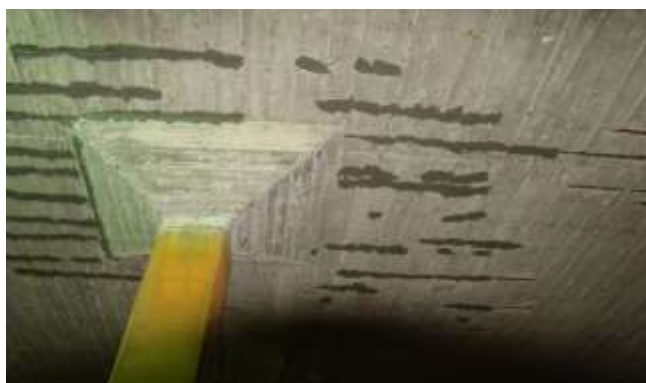
شکل شماره (۱۹) پر نمودن محل های تخریب شده سقف با استفاده از ملات ترمیم کننده در محل میلگرد ها
