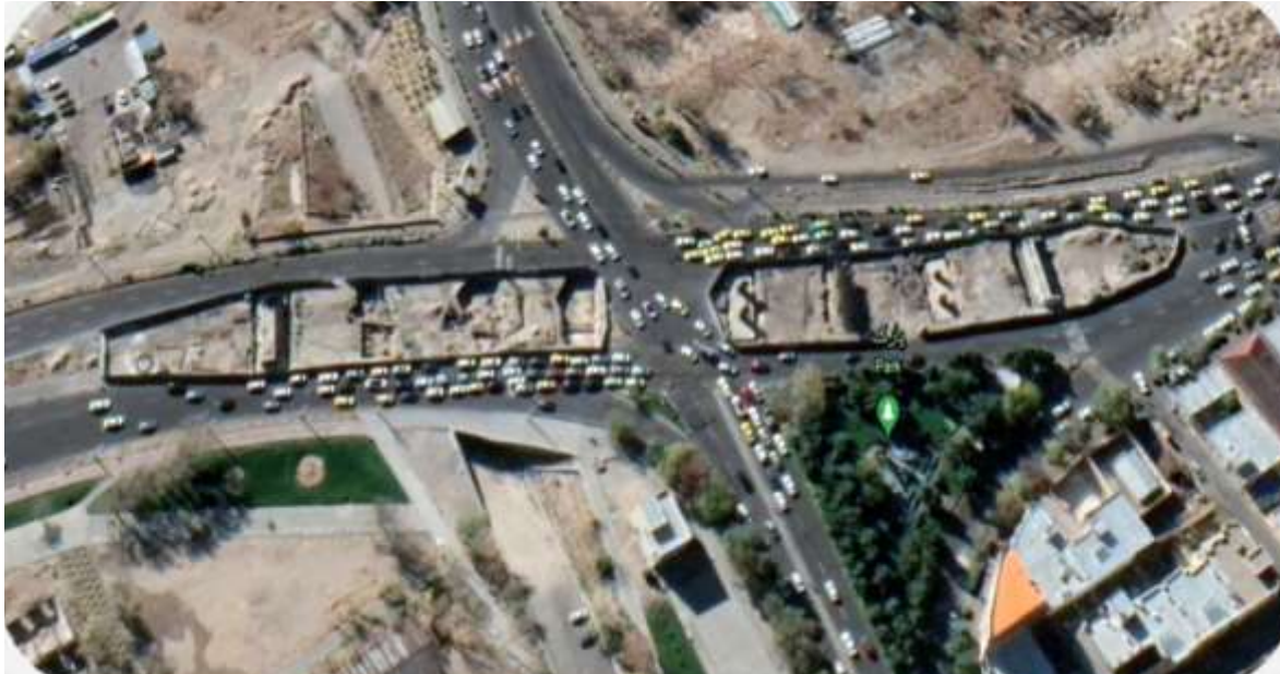
شکل شماره (۱): تصویر هوایی از روگذر غیرهمسطح ارتش-آزادی تبریز
