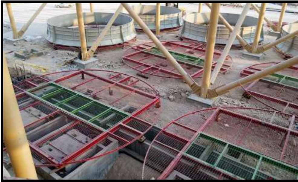
شکل ۱: نصب سازه ACC نیروگاه
