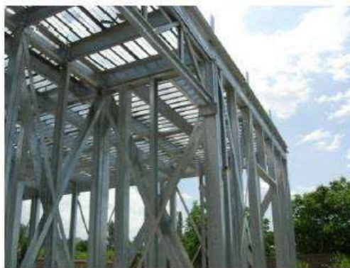
شکل - 2 ب) مهاربندها در سیستم
