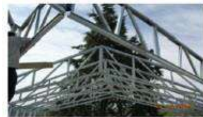
شکل ۳-الف) سقف خرپایی متشکل از مقاطع
