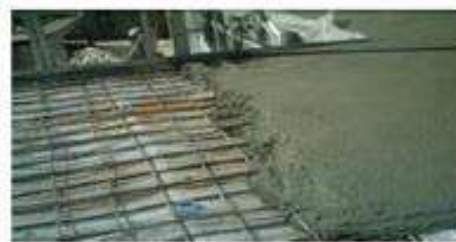
شکل ۳-ج) اجرای دال بتنی بر روی روفیکس و تیرچه ها در سقف مسطح.
