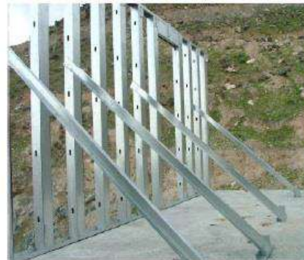
شکل - 2 الف) نصب کردن استادها و رانرها
