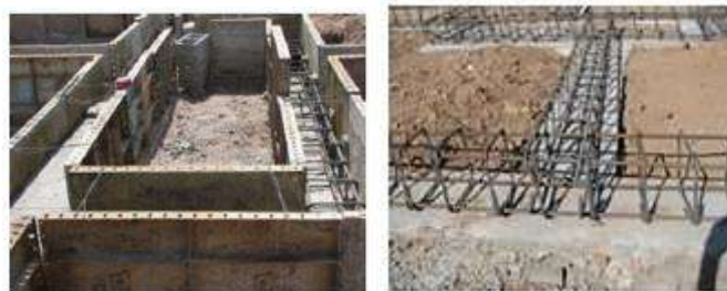
شکل 1-ب) قالب بندی
