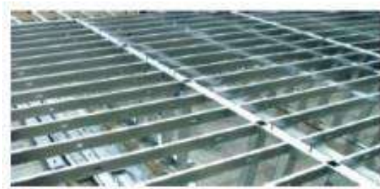
شکل ۳-ب) تیرچه ها در سقف مسطح
