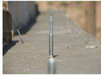
شکل - 1 ج) کارگذاشتن انکربولت ها با فواصل 60 سانتی متری برای نصب دیوار
