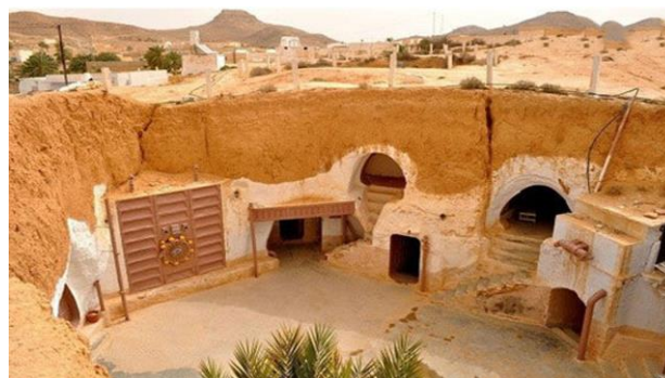
شکل (۱): خانه‌های زیرزمینی در روستای ماتماتا (در جنوب کشور تونس)
