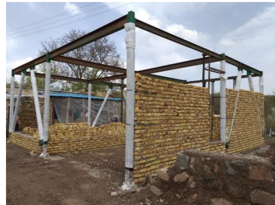
● ساخت بناهای فلزی با استفاده از بادبند و وال پست
