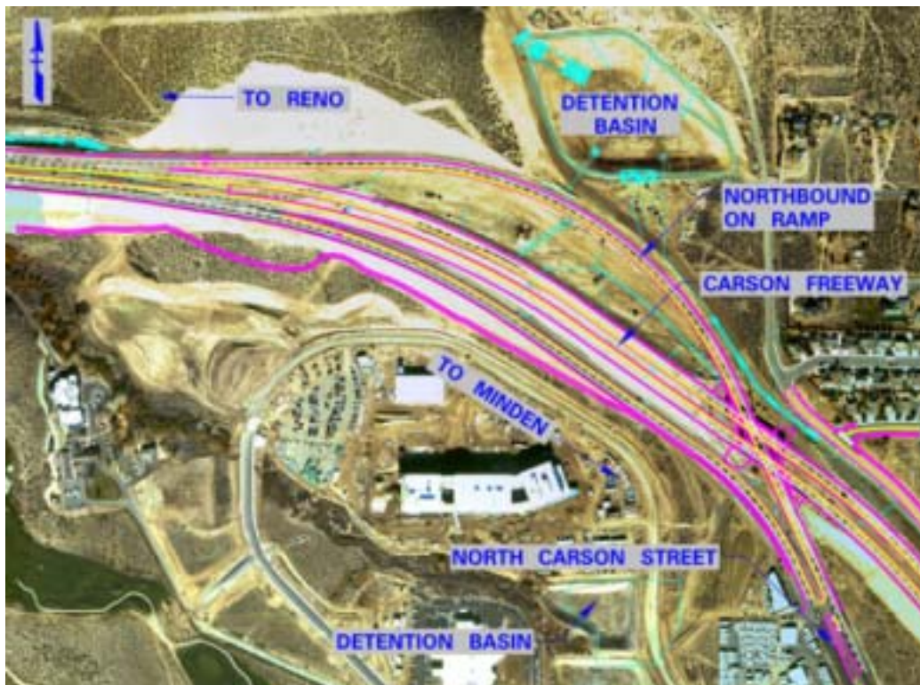
شکل ۲- نمایی از عملیات ساخت تقاطع ناهم سطح
