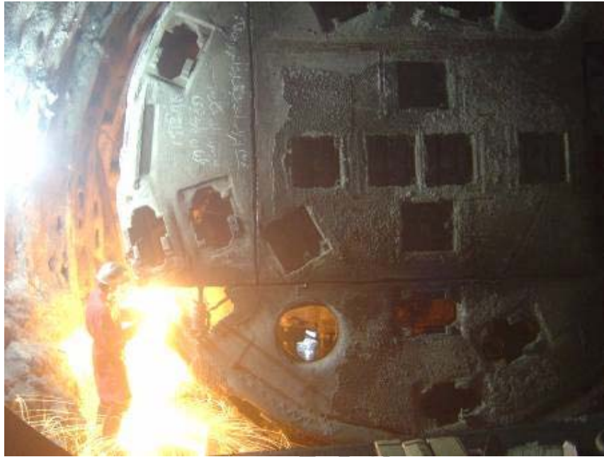
تصویر (۳): دمونتاز قطعات کلگی در داخل تونل [۲].
