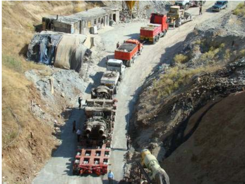
تصویر (۴): دمونتاز انتقال شافت اصلی دستگاه توسط بوژی به خارج از تونل [۲].
