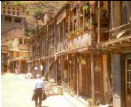
شکل ۹: نمایی از خانه های ماسوله با ستونهای چوبی
