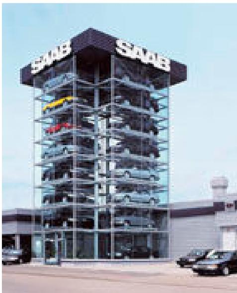
شکل (۷) نمایی از سامانه قفسه مرتفع Cross Parker
