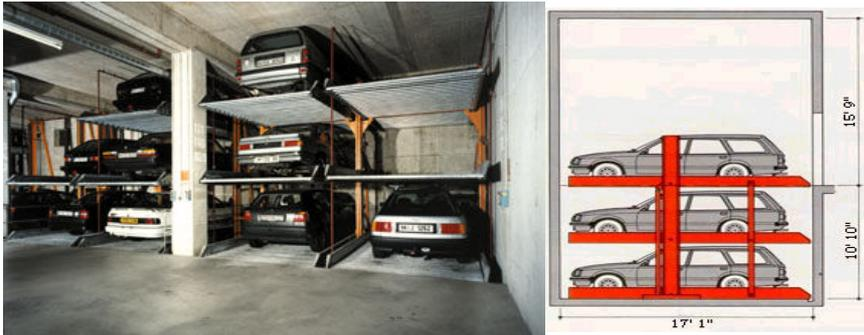
شکل (۴) نمونه سه طبقه از سامانه انبارهای کم ارتفاع Low Rise Stackers
