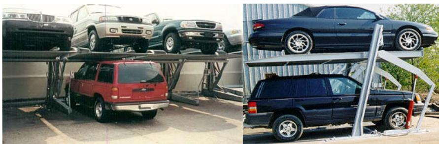
• شکل (۳) نمونه دو طبقه از سامانه انبارهای کم ارتفاع Low Rise Stackers
