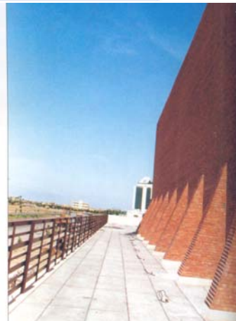
تصویر شماره ۱۳: پشت بندهای دیوار مجموعه ورزشی رفسنجان
