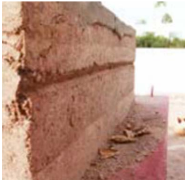
تصویر ۴ 6RX1FH 3URI 0 DV + D1GQ± 7KH formation of Voids and Niches in Rammed Earth
