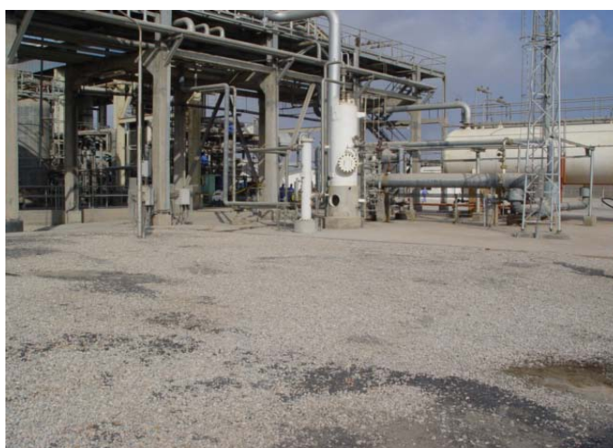
شکل ۳- نمایی از فیلتر کوالیسی توربین های رستون
