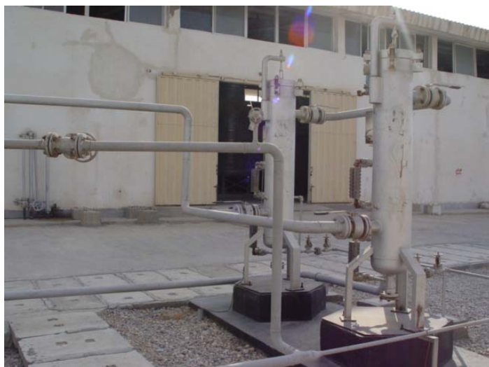
شکل ۲- نمایی از فیلتر کوالیسی توربین های Solar
