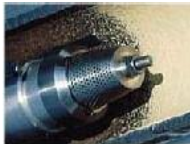
شکل (۳) نازل اسپری کننده رزین اپوکسی در درون لوله [ ۱۱ ] .
