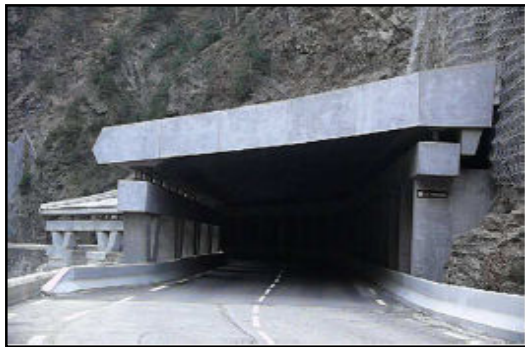
شکل ۶- گالری ضد ریزش در مسیر جاده [۲]
