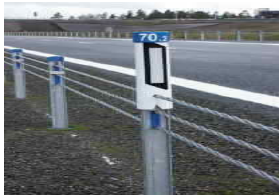
شکل ۹: نصب رفلکتور بر روی پایه ها
