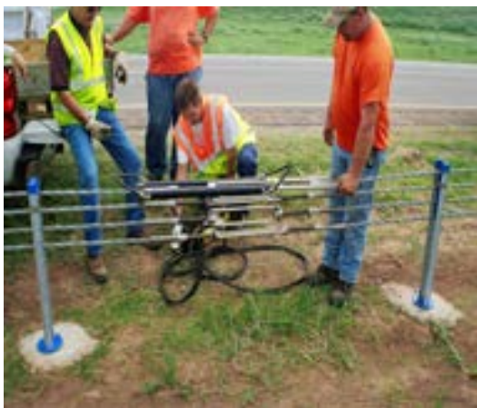
شکل ۸: تنظیم کشش کابل در طول توسط بست های قورباغه ای
