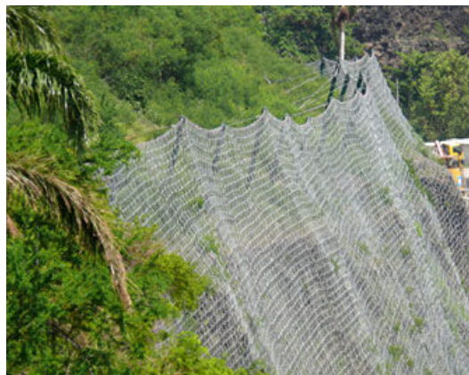
تصویر ۲- روش کاور کردن با شبکه فنی منعطف شونده
