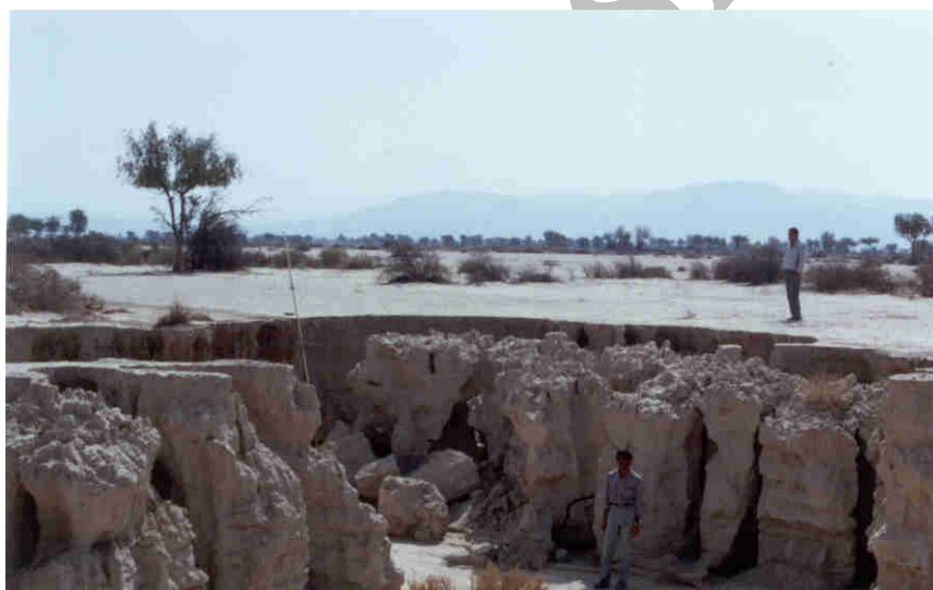
شکل (۳) ریزش توده ای خاک در راس آبکند در اثر تونلی شدن
