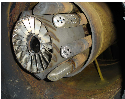
شکل (5-ب): تعویض نازل‌های گاز و ترمیم استابلایزرها
