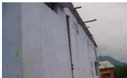
شکل 3 شکست خارج از صفحه‌ی دیوار و چرخش آن مانند یک جسم صلب
