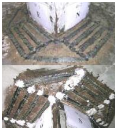
شکل (5): نحوه به کار بردن رکابی و خاموت های CFRP [7]
