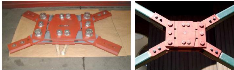
شکل (1): نمونه اجرا شده میراگر اولیه پال [4]
