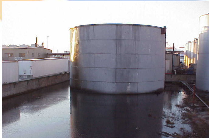
شکل ۹. نقش باندوال در محصور کردن نفت پس از خرابی مخزن و تخلیه
