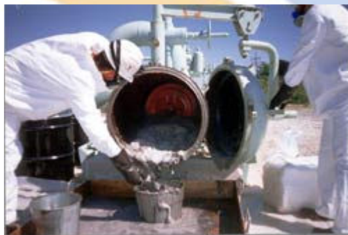
شکل ۱۲. پاکسازی لوله‌ها با Pigging
