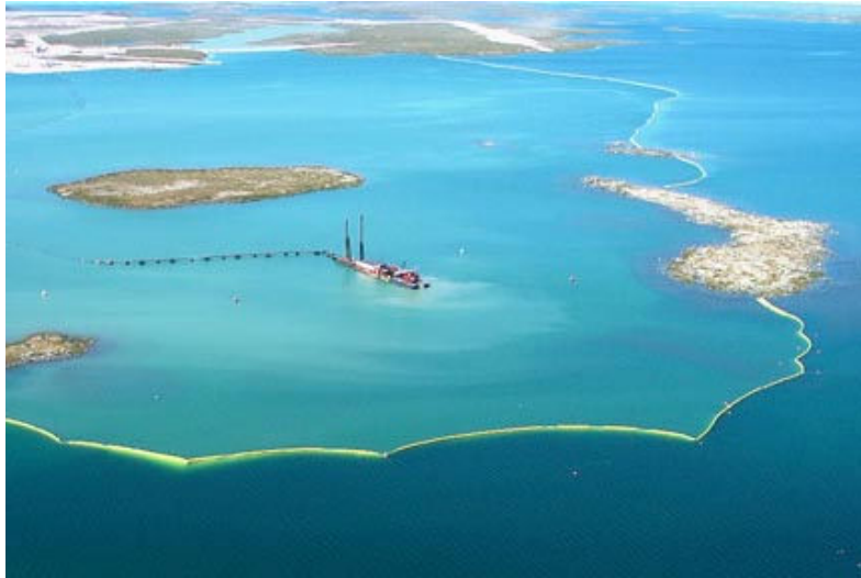
شکل ۸. نمونه ای از کاربرد موانع قائم شناور به منظور جلوگیری از انتشار کدورت حین لایروبی
