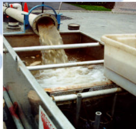
شکل ۱۱. شست‌وشوی لوله‌ها (Flushing)
