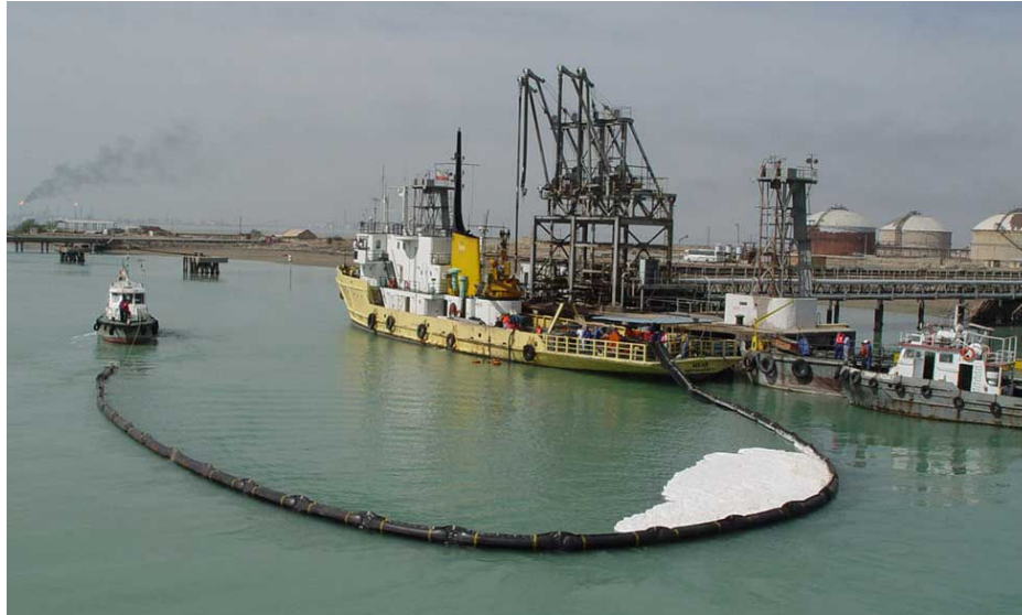
شکل ۱۰. نمونه ای از بازوهای شناور برای جلوگیری از انتشار نفت (بندر امام خمینی، بهمن ۱۳۸۶)
