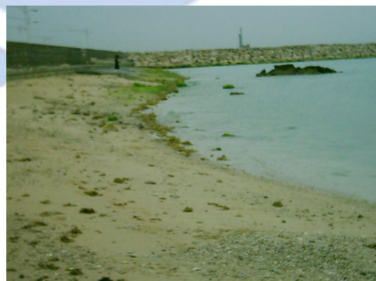
شکل ۵: تصویر اسکله صیادی (شمال شرقی)
