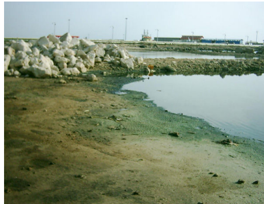
شکل ۶: تصویر اسکلّه شرقی (ترمینال T-jetty) (شرق)
