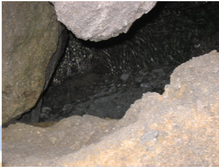
شکل ۲: عدم وجود لایه های مشخص مغزه و فیلتر در ۸۰ متر انتهایی
