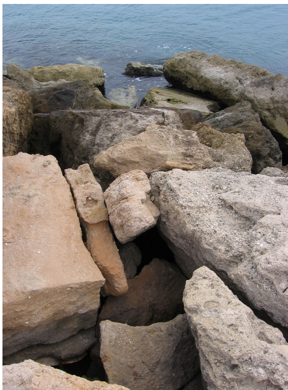
شکل ۳: جابجایی قطعات آرمور و عدم قفل و بست کافی
