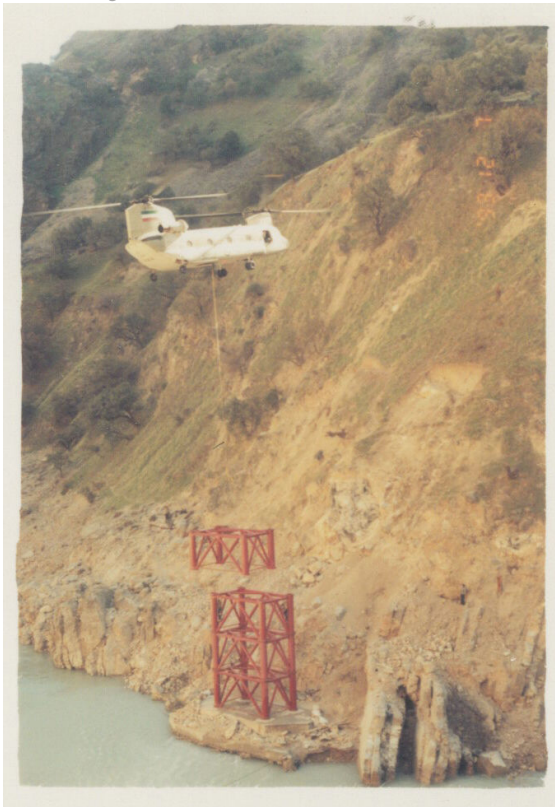
شکل ۱۷- نصب پایه‌های پل پس از اجرای فونداسیون
