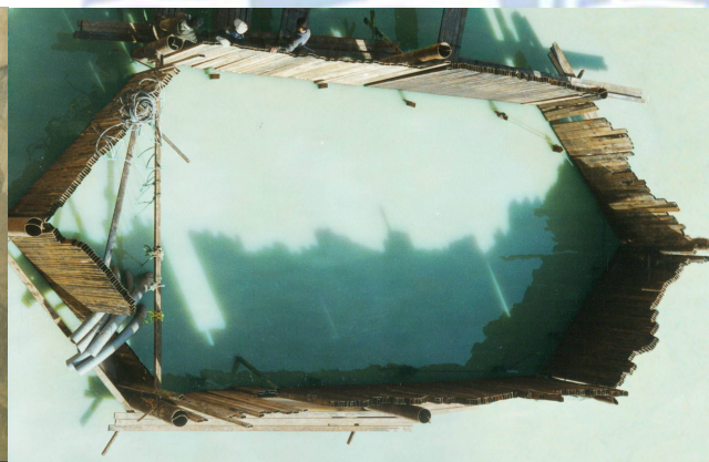
شکل ۱۴- مونتاژ کامل قالب در محل
