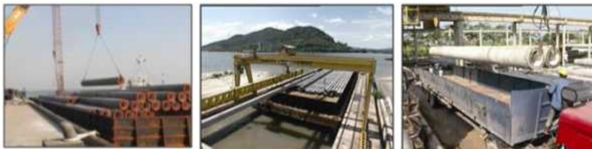
شکل ۱۳) بارگیری شمع‌ها روی تریلی (حمل از خشکی) و بارج (حمل از دریا) جهت حمل به محل پروژه
