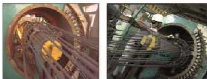
شکل ۳) عبور میلگردها از شابلون و عملیات ساخت قفس
