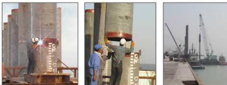
شکل ۱۴) کوبش شمع‌های پیش‌تنیده سانتریفوژ و روش اتصال آنها در محل اجرای پروژه
