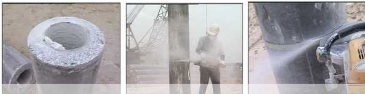
شکل ۱۵) استفاده از فرز مخصوص جهت برش شمع پیش تنیده سانتریفوژ در کد ارتفاعی مورد نظر
