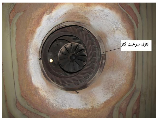
شکل ۲- نسوزکاری اطراف مشعل
